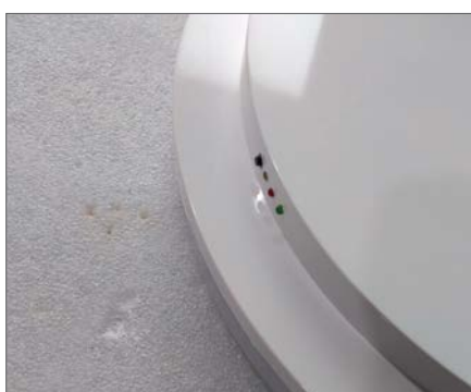
Kontrolleuchten Notlicht
